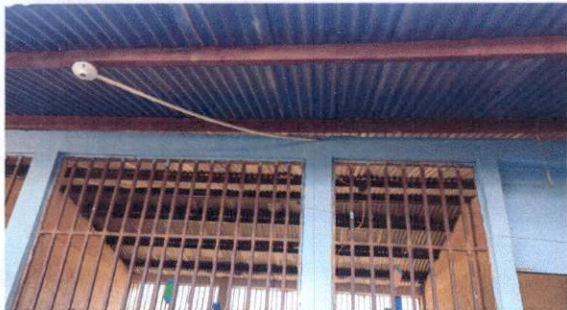
Foto 1: Cambio de techo
