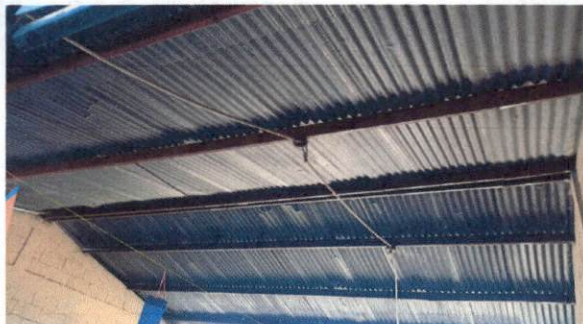
Foto 2: cambio de techo y mantenimiento de estructura
