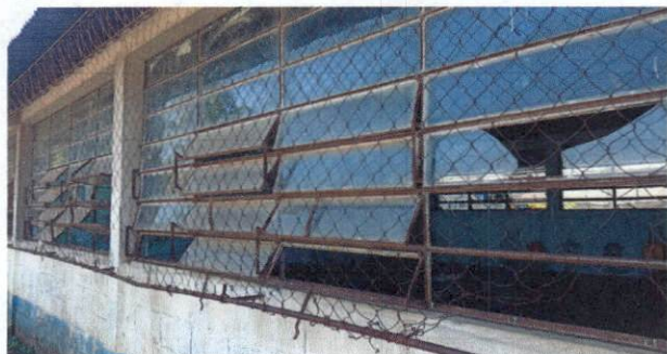
Foto 5: mantenimiento de balcones
