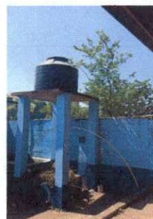
Foto 6: sustitucion de deposito de agua.
