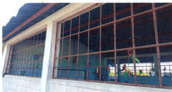
Foto 3: mantenimiento de balcones
