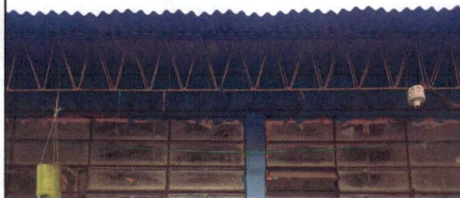
Foto 4: Cambio de techo y sustitucion de estructura de soporte
